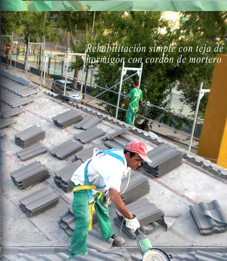
Perfiles para rectificar faldón irregular
