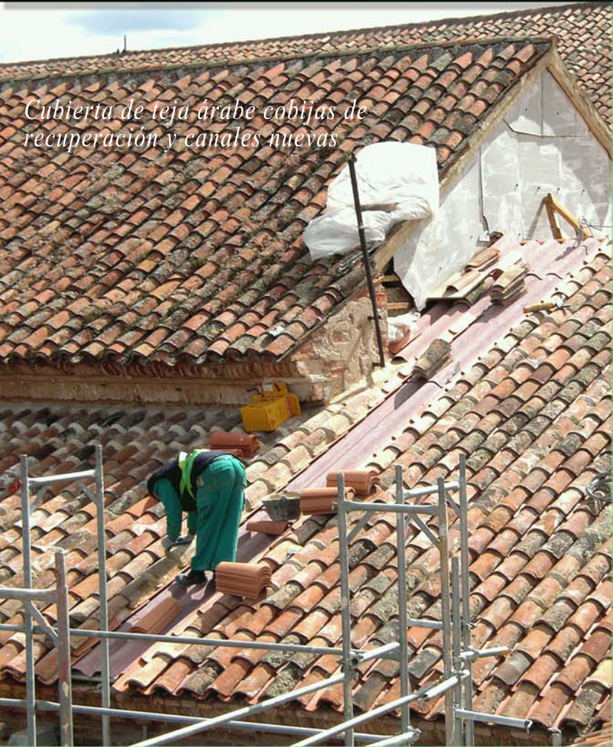
Encapsulado de placas de Fibrocemento
