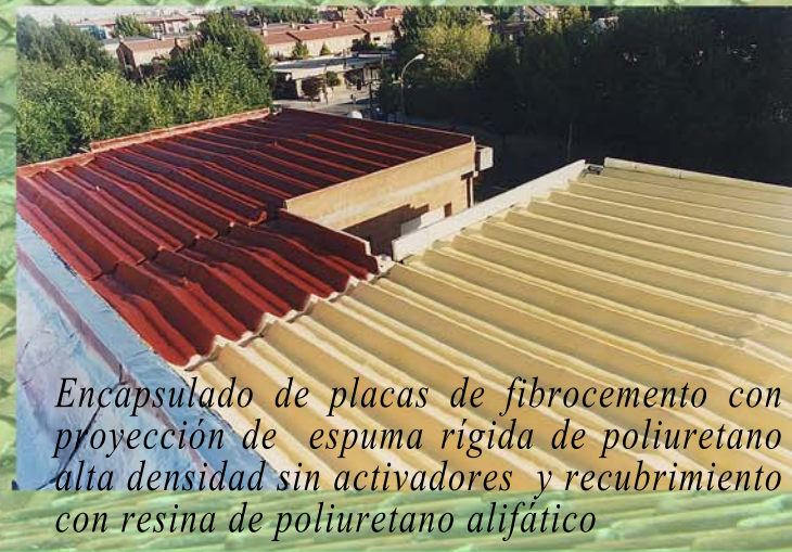
Encapsulado de placas de Fibrocemento
