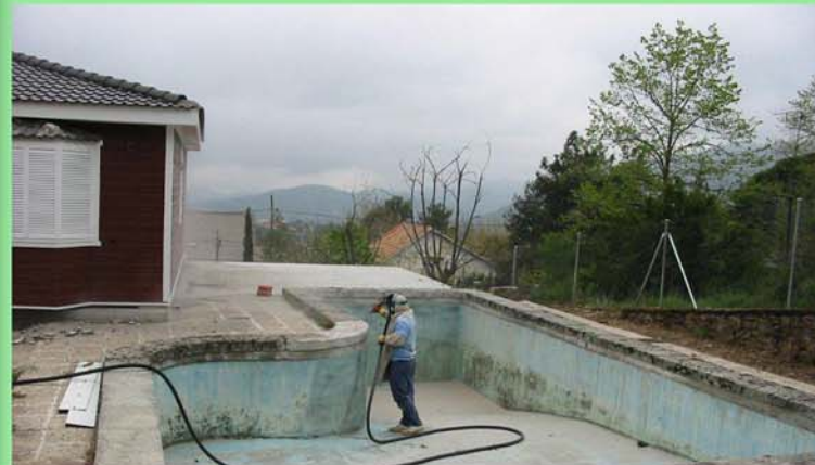
Limpieza del soporte por chorro arena
